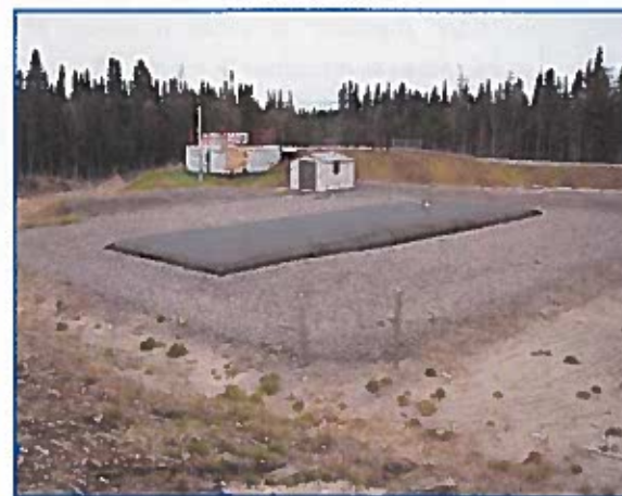
Station de traitement des boues située à Longue-Pointe-de-Mingan
